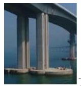
D. 大桥的桥墩
